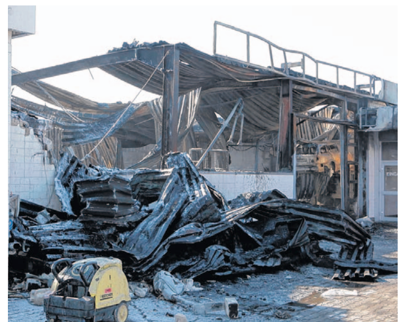
Ein Feuer brach am Donnerstag in einem Autohaus in Lampertheim aus, zerstörte das Gebäude, eine weitere Autohalle und teilweise eine Kfz-Prüfstelle. BILD: NIX
